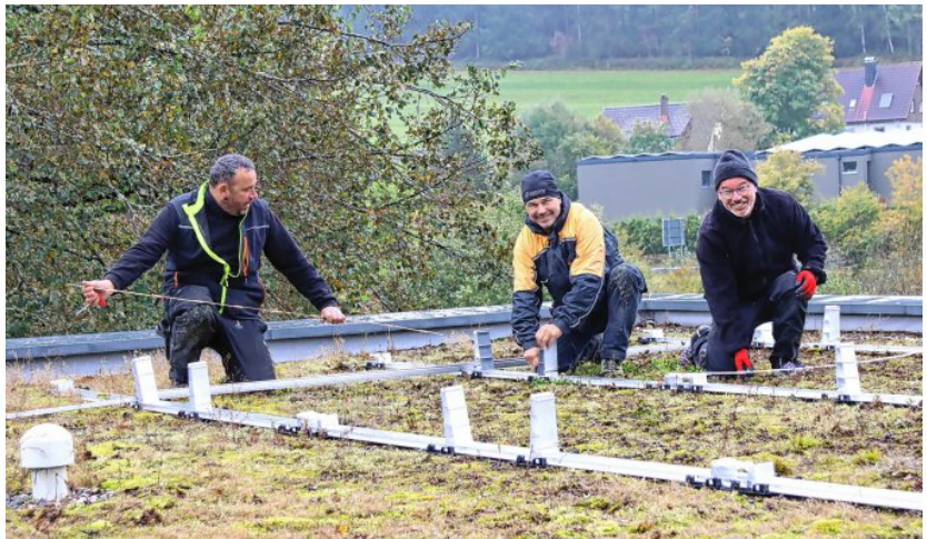
Oliver Späth (von links), Patrick Seng und Michael Lösle beim Aufbau der Photovoltaikanlage auf dem Dach des Kabinentrakts des Fußballclubs Alemannia Unterkirnach. BILDER: CORNELIA PUTSCHBACH
